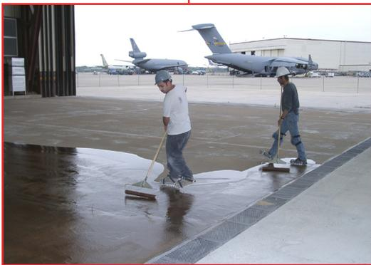
Las instalaciones de mantenimiento de aeronaves utilizan productos químicos agresivos para la limpieza de piezas y motores, y la eliminación de pintura. **PENNCOAT™ Lining** o el **PENNTROWEL™ SB Flooring** adecuadamente seleccionados brindan una protección efectiva del concreto en estas instalaciones.
