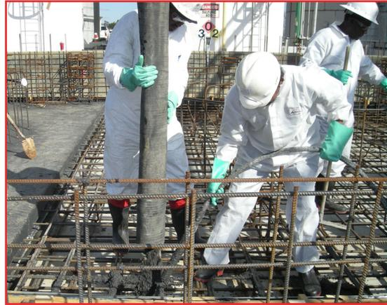
**TUFCEM™ Silicate Concrete** es un cemento resistente a ácidos sustituto del tipo Portland. Esta planta que fabrica ingredientes farmacéuticos activos, la cual usa ácido sulfúrico concentrado y ácido acético construyó los diques de contención secundaria utilizando **TUFCEM™ Silicate Concrete** que fue mezclado en obra con camiones de capacidad volumétrica continua.
