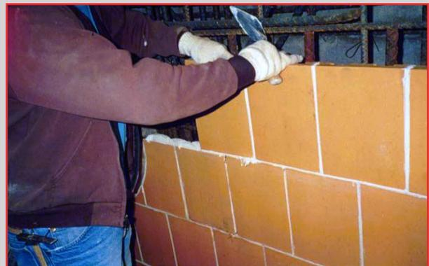
Los morteros de viniléster se han utilizado históricamente en equipos de plantas de blanqueo de pulpa revestidos de loseta antiácido. Nuestra familia de viniléster **PENNCHEM™ Mortars** proporciona un funcionamiento eficiente para soportar las variaciones en el pH y la temperatura para una durabilidad óptima del mortero.
