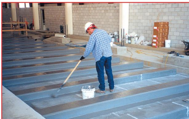
Los revestimientos **PENNCOAT™** y **PENNCOAT™ MR** son fáciles de usar y soluciones prácticas y rentables para estructuras de contención secundarias diseñadas para resistir salpicaduras y derrames químicos ocasionales.
