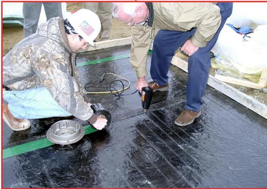
Cuando el tiempo de instalación es limitado, considere una membrana de lámina previamente curada y unida adhesivamente, como la **Membrana PENNCOAT™ 600**. Las costuras están selladas con cinta resistente al calor y a los productos químicos.
