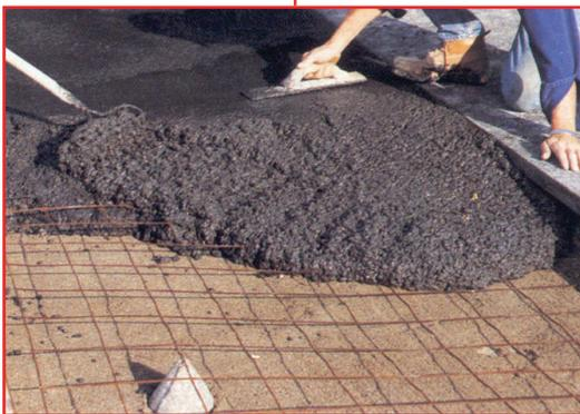
Cuando el cronograma de su proyecto no proporcione el tiempo suficiente para instalar pisos de ladrillo antiácido, sustitúyalo por un concreto polimérico vaciado en sitio para un avance más rápido. Para plantas de baterías y otros ambientes ácidos, considere pisos **TUFCEM™ Silicate Concrete** o **TUFCEM™ Epoxy Concrete**.
