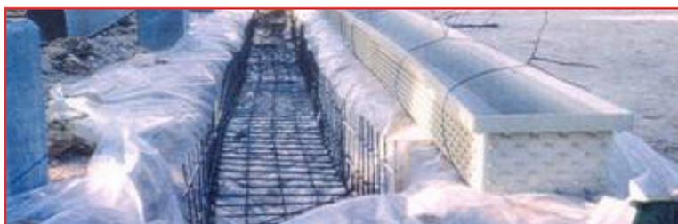
Cuando el tiempo de paro es crítico, los sistemas ACROLINE™ prefabricados y los revestimientos de trincheras ahorran un tiempo considerable de construcción: el concreto puede vaciarse y revestirse en el mismo paso.
