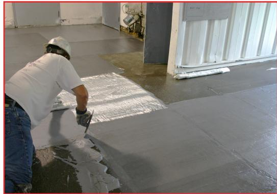
En comparación con los sistemas llaneables **PENNTROWEL™ Surfacer Systems, PENNTROWEL™ SB Systems** se aplican con técnicas autonivelantes con menor tiempo de horas hombre. Estos métodos producen un acabado antideslizante y duradero.
