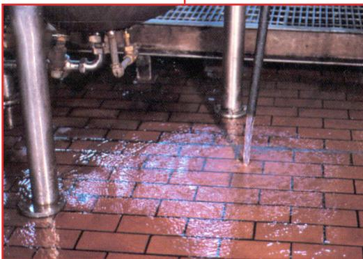
Con una durabilidad comprobada por años y resistencia al choque térmico, pocas alternativas duran más que un **piso de tabique antiácido con membrana** bien especificado, instalado y mantenimiento adecuado.
