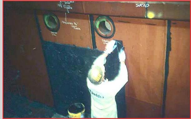
En entornos ácidos sujetos a ciclos térmicos, la adición de una capa de **PENNGUARD™ Block Lining System** detrás del ladrillo aísla la membrana y extiende su vida útil.
