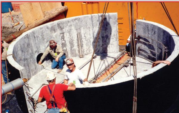
Se usó **Urethane-asphalt TUFCHEM™ II Membrane** para recubrir la superficie exterior de este pozo de azufre hecho de **TUFCHEM™ Silicate Concrete**. El pozo de azufre fue prefabricado en dos piezas y luego se unió.
