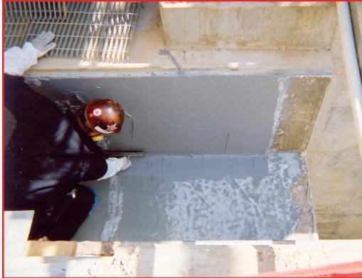
Los sistemas **PENNTROWEL™ MR y L/F** reforzados con fibra de vidrio pueden soportar la inmersión química constante y la abrasión del sedimento arrastrado en las corrientes de aguas residuales. El refuerzo también ayuda a estos revestimientos a mantener su integridad a lo largo de las esquinas interiores, donde el ciclo térmico estacional podría socavar un sistema de revestimiento más débil.
