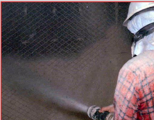
En chimeneas predominantemente calientes y secas, **TUFCHEM™ Silicate Gunite** recubrimiento multicomponente es una opción económica. Para un mejor rendimiento, el sustrato y el sistema de anclaje se recubren primero con una membrana resistente a los químicos, como **PACMASTIC™ 325**, antes de la instalación de **TUFCHEM™ Silicate Gunite**.
