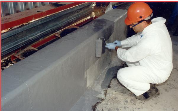
Las formulaciones con cargas laminares de nuestros revestimientos **PENNCOAT™** reducen la permeabilidad del revestimiento para una mayor vida útil en el servicio de inmersión. Los sistemas están diseñados para la aplicación con brocha, rodillo, llana y aspersion.
