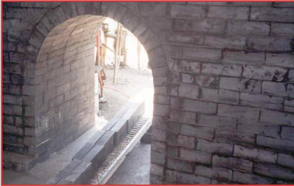
Los tanques de ataque de ácido fosfórico están revestidos con **tabique de carbón** juntado con **FURALAC™ Green Panel** Mortar sobre una membrana resistente a los químicos como **TUFCHEM™ II Membrane**.
