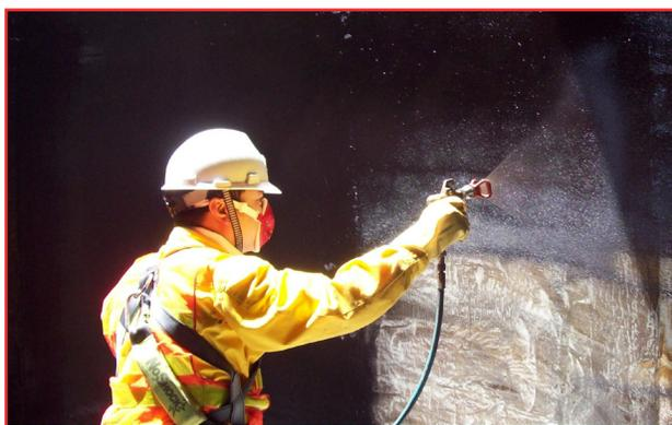
La naturaleza elastomérica de las membranas **TUFCEM™ II** y **Pennchem™ 97** les permite acomodar algún movimiento en los sustratos sobre los que se aplican. Ambos son útiles revestimientos de contención secundaria.
