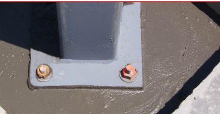
Las placas base de columna necesitan un soporte sólido para una transferencia de carga eficiente. **TUFCEM™ Grout** de alta resistencia es una excelente opción para vertidos de hasta un pie de profundidad
